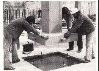
Hohe Gebäude mit schweren Deckennutzlasten verlangen schwere Stützen. Stützen-Montage für das Fernbetriebszentrum der PTT-Betriebe in Zürich-Herdern.
