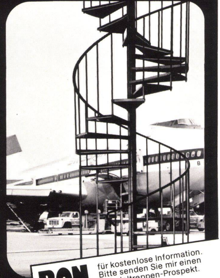
Nottreppe am neuen Fingerdock in Kloten
