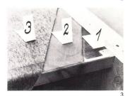
Treppenwinkel über die ausgelaufene Treppenkante gelegt und festgenagelt.
