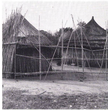
1 Juba: Strohüttengehöft. 2 Juba: Hüttenwand (Holz-Bambus-Traggerippe) mit Lehm verfüllt. 3 Juba: Ladenbau. Holz-Bambus-Traggerippe mit Natursteinfüllung. Wellblechdach. 4 Khartoum-Nord: Rundhütten. Wände und Kegeldach aus gebrannten Ziegeln gemauert bzw. gewölbt. 5 Port Sudan: Straßenansicht Holzhäuser mit umlaufenden Veranden.
