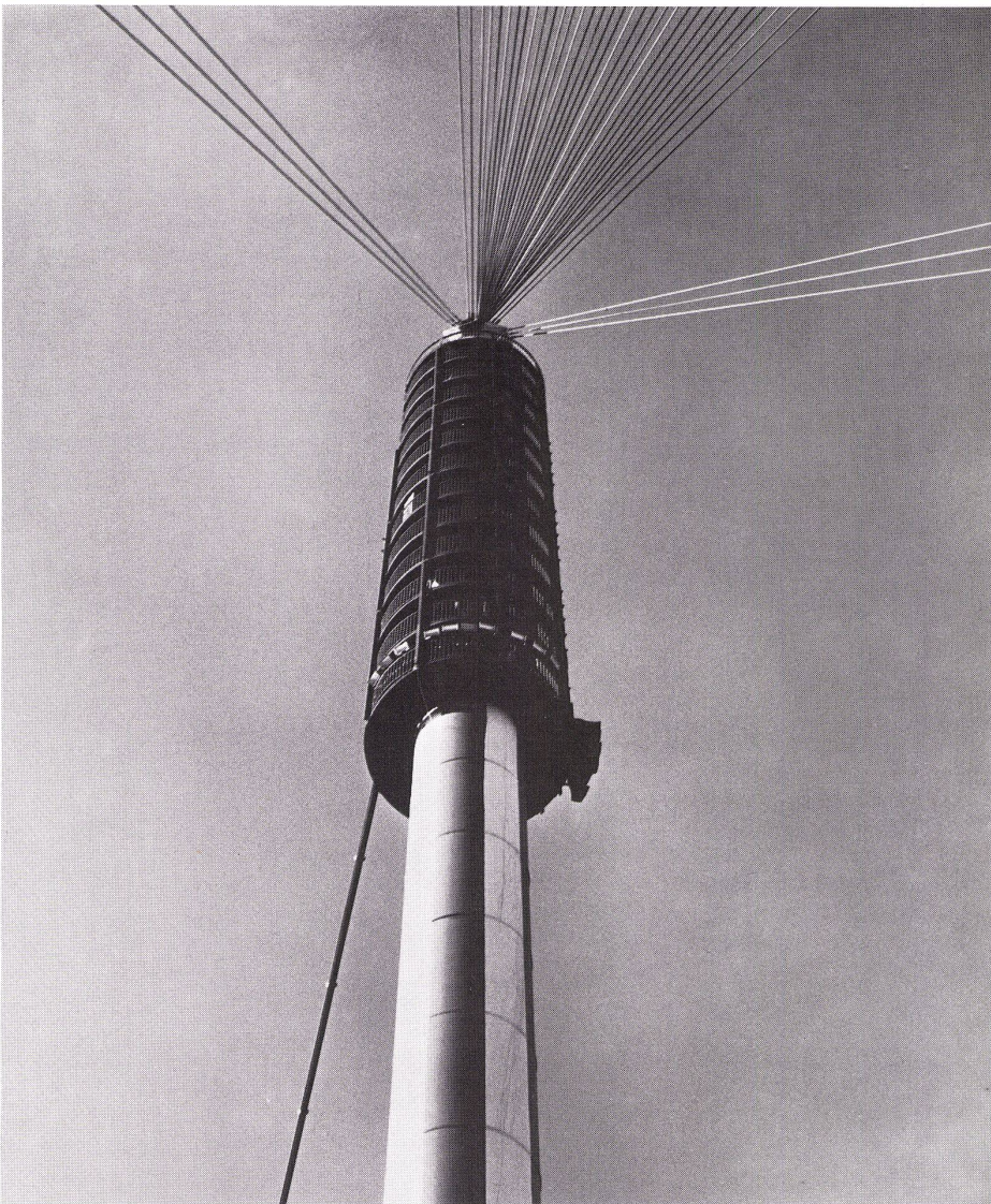
5, 6 Aufsicht und Ansicht der Seilnetzkonstruktion. La structure en filet de cables vue en plan et en élévation. Top view and elevation view of the cable-network construction.
