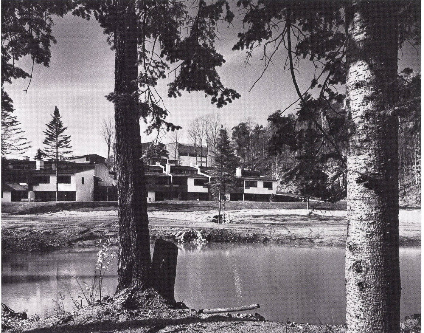
2 Gesamtansicht. Vue générale. Assembly view.
