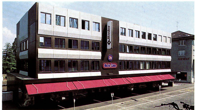
Geschäftshaus, CH-Thalwil, 1976 INFRASTOP-Auresin 39/28 Arch. G. Theiler, Thalwil
