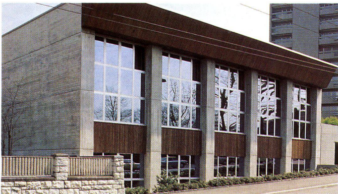
Turnhalle Schulhaus Riedtli, CH-Zürich, 1975 INFRASTOP-Auresin 39/28 Arch. A. Notter, Zürich
