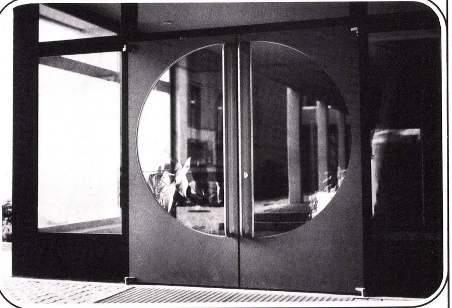
Eingangspartie in Leichtmetall-Konstruktion
