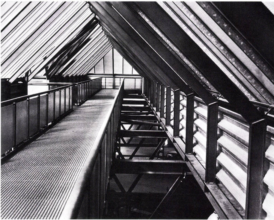
9 Verbindungsbrücke über der Fuhrparkhalle auf der Höhe des 2. OG. Passerelle de liaison enjambant le dépôt des véhicules au niveau de 2ème et. Connecting bridge over the garage at level of 2nd floor.
