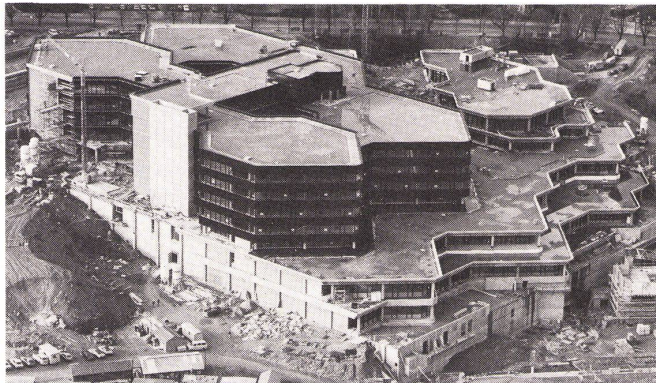
SKA-Neubau Uetlihof Zürich 28'000 m 2 Sarnafil
