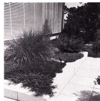
Optima-Dachgarten in Oberwil BL Schichtaufbau: 17 cm Baujahr 1969
