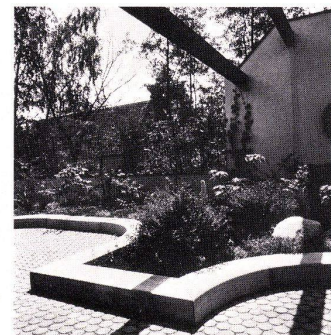
Optima-Dachgarten mit neuen Bogen-Randelementen Schichthöhe: 35 cm und 17 cm (Bild) Baujahr 1978
