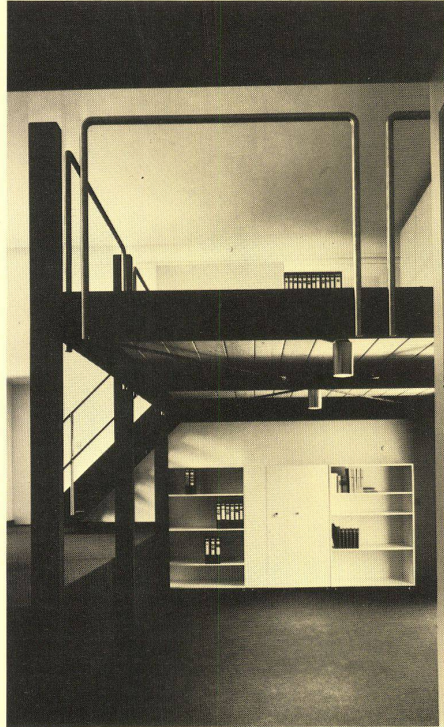
7 Ausgang zum Garten mit Pförtnerloge. Sortie vers le jardin avec loge de portier. Exit to the garden with caretaker's office.
