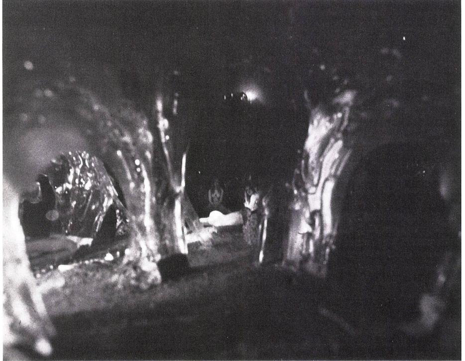
Die von einer Gruppe aus Architekten, Ingenieuren und Künstlern durchgeführten Kuppel-Versuchskonstruktionen aus flüssigem Acryl wurden mit der Absicht unternommen, mit einfachsten Mitteln und Methoden nutzbare ein- und mehrschiffige Kuppelräume herzustellen.
