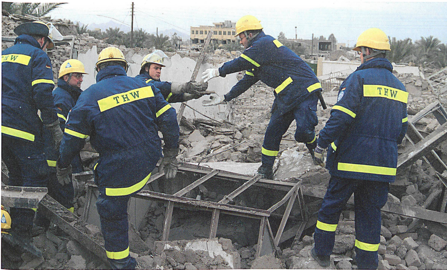
Das THW ist weltweit im Einsatz, etwa auf der Suche nach Verschütteten oder bei der Versorgung der Bevölkerung mit Trinkwasser.
