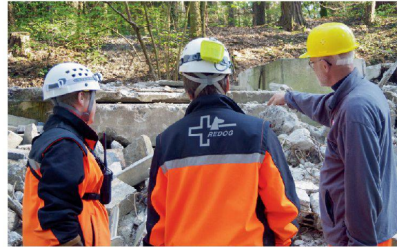
REDOG-Experten und ein Ingenieur bei der Raumerkundung auf dem Schadenplatz.
