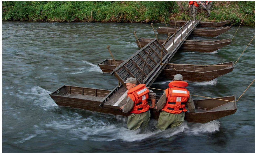
Innert 75 Minuten hatten die Pioniere zwei Stege eingebaut, befestigt und beleuchtet.
