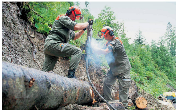
Im steilen und rutschigen Gelände sichert der Zivilschutz mit Holzkästen eine Strasse.
