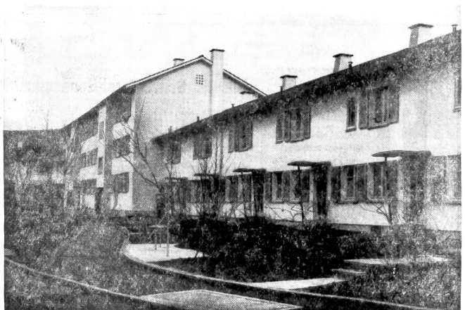
Schöne Partie aus der bekannten ASIG-Siedlung in Schwamendingen, Zürich 11. Diese landschaftlich wohlige Genossenschaftskolonie wurde im Rohbau aus Durisol-Mauersteinen erstellt.
