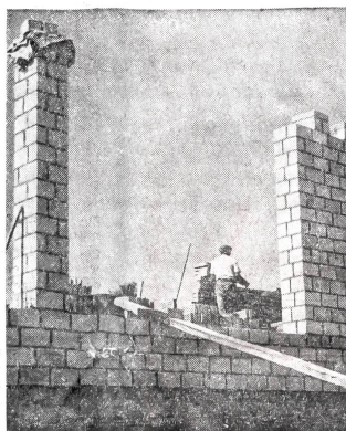
Der Normalstein im Format 25/12/6 cm kann als der klassische Backstein bezeichnet werden, denn er wurde schon vor Jahrtausenden hergestellt, allerdings ohne Lochung.
