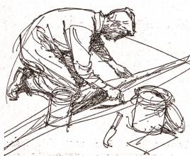
Linoleumleger beim Kleben des Bodenbelages. (Köllä)
