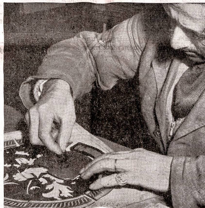
Die ausgeschnittenen Stücke werden mit einer Bleimasse bestrichen, worauf Formen aufgezeichnet und dann mit einem feinen Federmesser ausgeschnitten werden.
