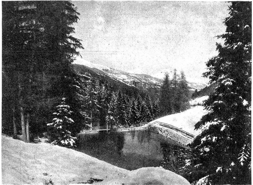
Talsperre in Churwalden: Ansicht der Staumauer von der obren Seite mit Kieschleufe und Einlaufschleufe, sowie Stauweiher mit Ueberfall.
