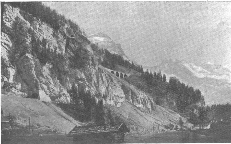
Löttschbergbahn: Die dreimal sichtbare Linienführung bei Blausee mit Aussicht auf Doldenhorn und Alts.
