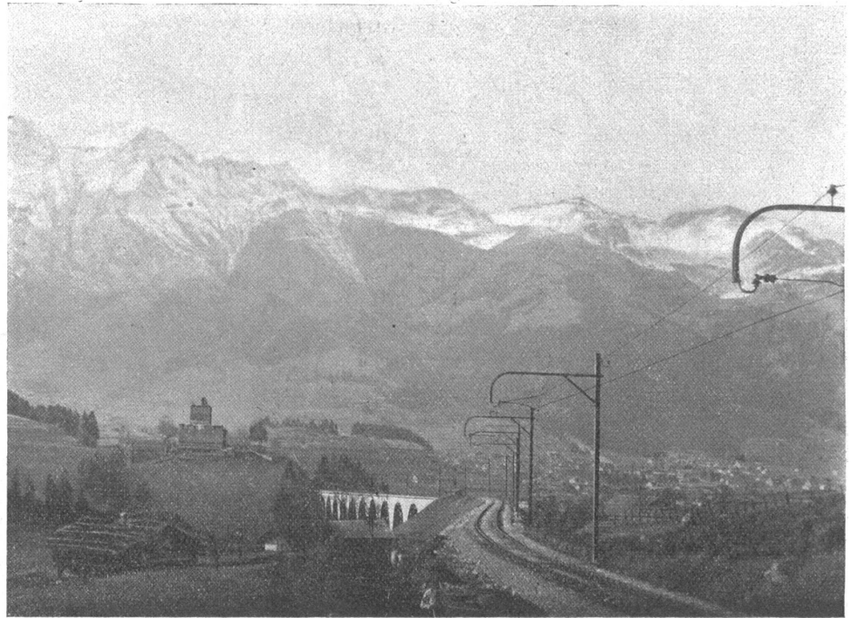
Löttschbergbahn: Kanderbladukt mit Tellenburg und Blick auf Srutigen.
