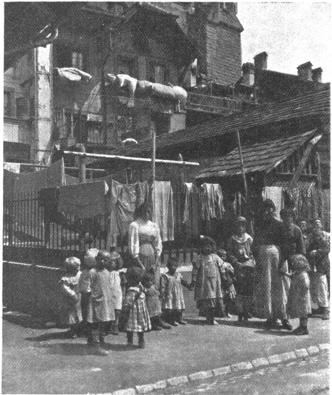
Häuser an der Badgasse in Bern mit Blick auf die Aarestrasse. 2)
