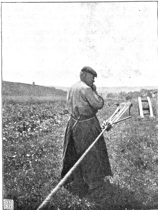
Leitholzführer beim Versellen eines Drahtseils durch Handfabrikation.
