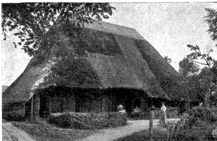
Alemannisches Haus. Strohhaus in Mienried bei Büren. Aufnahme von R. Minder, Biel.
