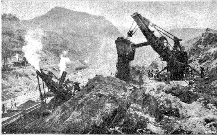
Dampföffelbagger im Culebra-Einschnitt, im Begriffe eine Rutschung wegzuräumen und provisorisch abzulagern zur Bedienung den tiefer stehenden, den Materialförderzug ladenden Dampföffelbaggers. Oktober 1912.
