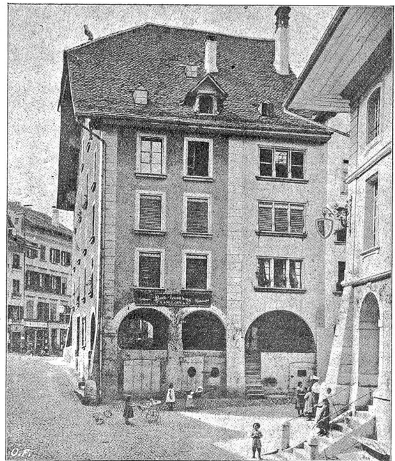
Das Fankhausersche „Großhaus“ in Burgdorf. Hohe-Gasse-Kirchbühl Ecke (Haus rechts stehend).
