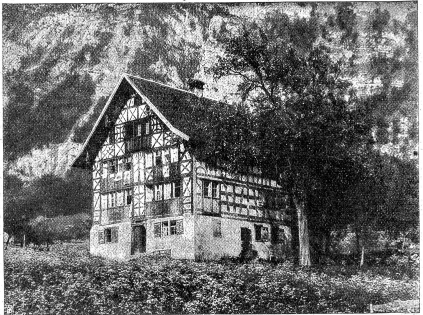
Fränkisches Haus. Fachwerk- und Riegelbau. (Netstal, Glarus.)
