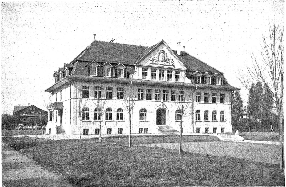
Das neue Seminargebäude in Thun. Gesamtansicht.
