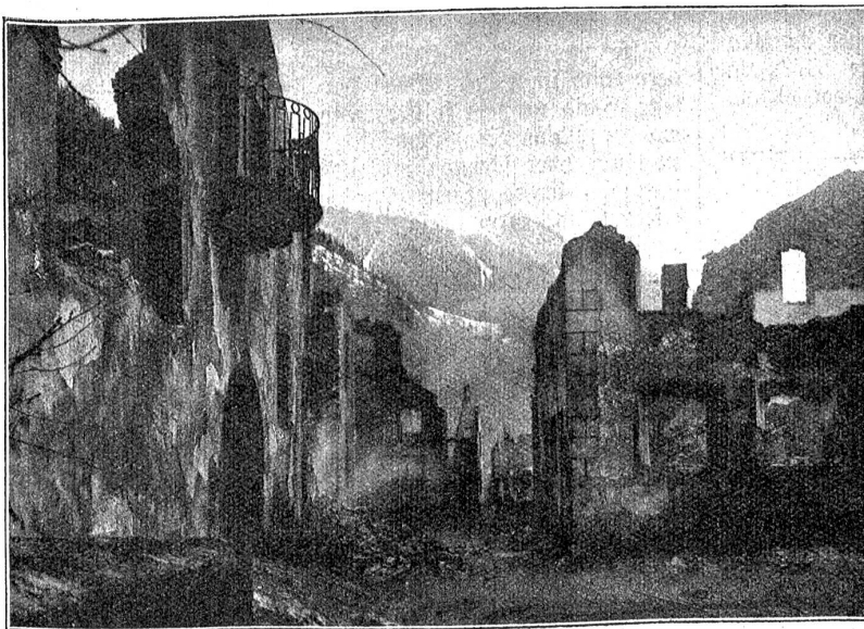
Süs. — Hauptstrasse nach dem Brande.
