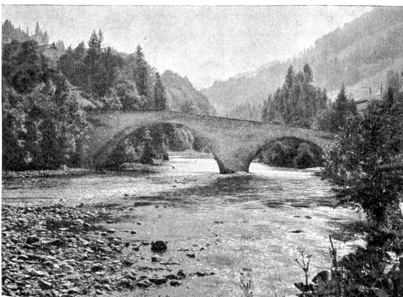
Abb. 4. Alte Steinbrücke über die Saane, Kanton Sriburg. Verschieden große Oeffnungen, den Gründungsverhältnissen angepaßt, der Scheitel über dem höhern Bogen.
