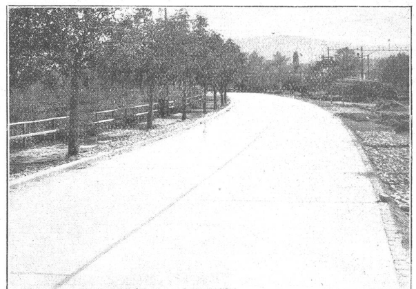
Betonbelag auf der Bahnhofstraße in Arbon, erstellt 1928.
