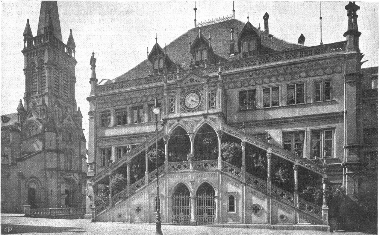
Das Berner Rathaus nach dem Umbau von 1866.
