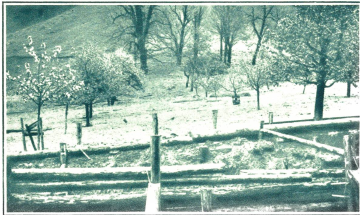
Feuerwehr-Schutzbauten gegen den Ausbruch der großen Rufe am Kilchenstock bei Linthal.
