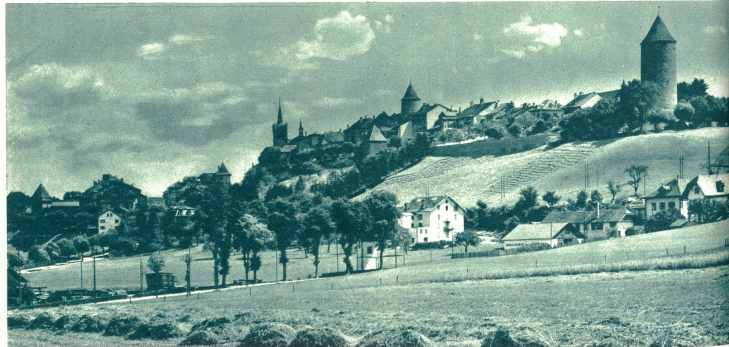
Romont, von Süden gesehen. Die alte Grafenstadt mit ihren mittelalterlichen Türmen hat immerhin als Schnellzugsstation an der Durchgangslinie Romanshorn—Zürich—Bern—Lausanne—Genf auch im modernen Leben eine gewisse Bedeutung gewahrt. Phot. A. Krenn, Zürich.
