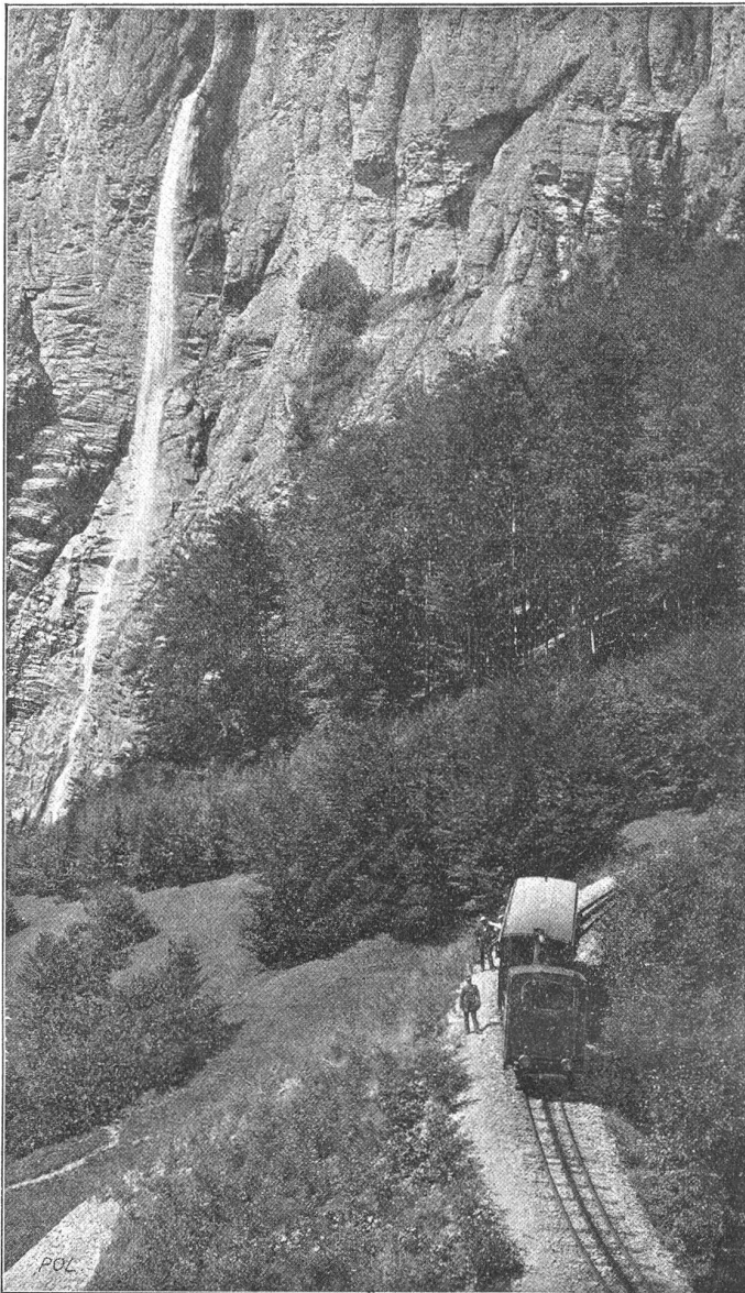
Die Briener Rothhornbahnlinie beim Mühlebadfall.
