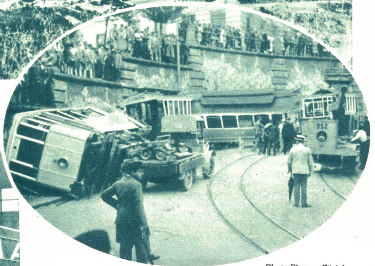
Phot. Pleyer, Zürich. Vom schweren Tramunglück an der Gloriosastraße in Zürich.
