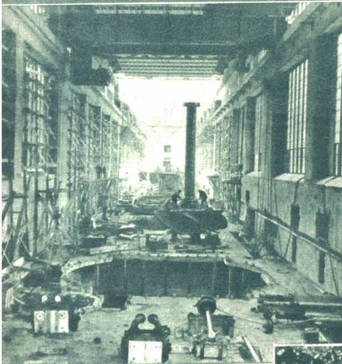
Das Großkraftwerk Kembs. Blick in die riesige Turbinenhalle. Im Mittelgrund wird eine der 33,000 P. S. Turbinen montiert und dann in die davor befindliche Kam- mer eingelassen. Unten: Der Oberwasserkanal be- ginnt sich mit Grundwasser des kleinern zu füllen, da derselbe nun nicht mehr abgepumpt wird.
