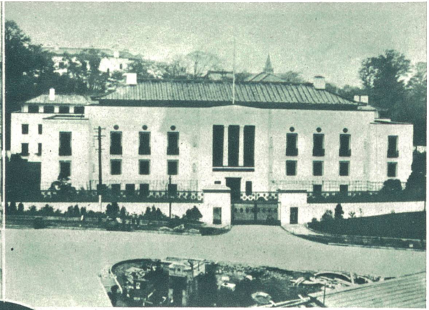
Das amerikanische Gesandtschaftsgebäude in Tokio. Japanische Nationalisten drohten kürzlich, dasselbe in die Luft zu sprengen.
