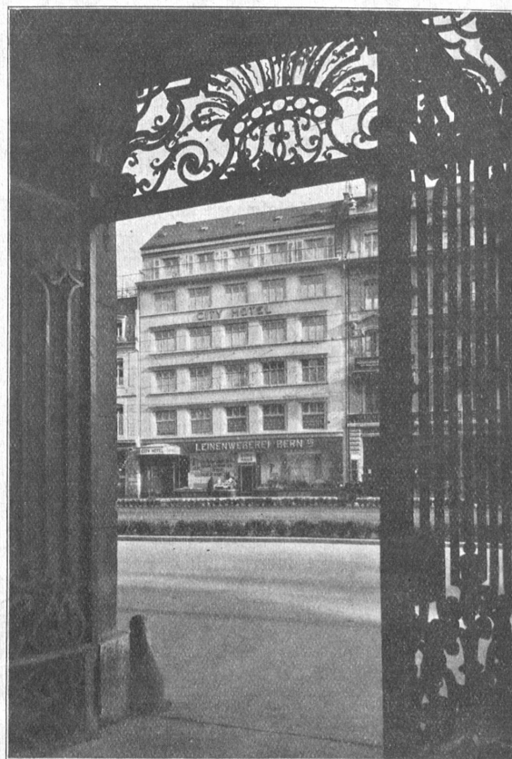
Das City-Haus und City-Hotel in Bern vom Portal des Bürgerhospitals aus.
