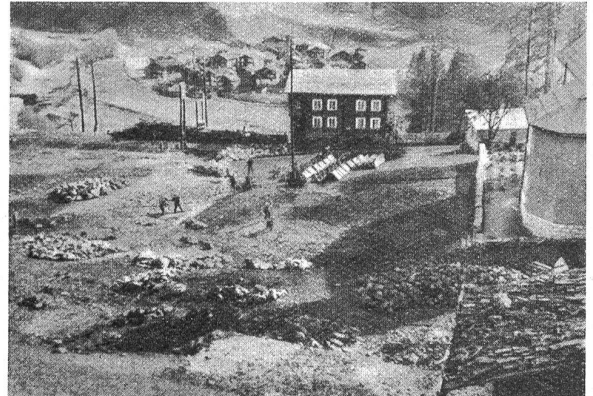
Der aufgeräumte Brandplatz.
