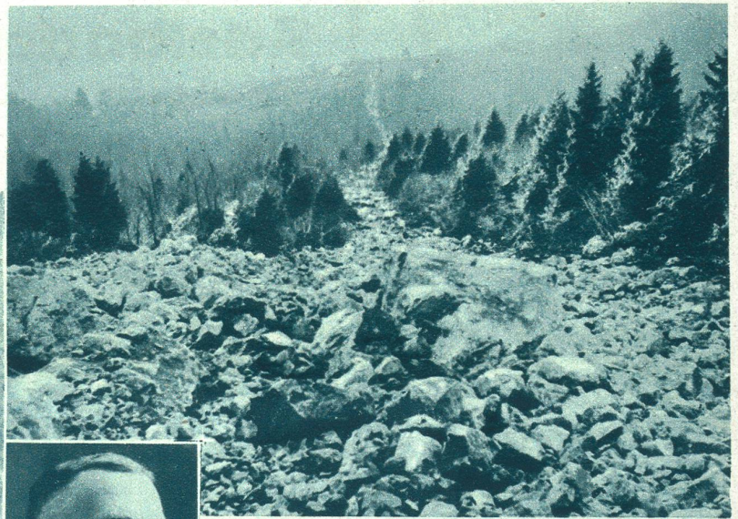
Felsstürze am Walensee. An der Kapfwand am Walensee, 600 Meter über dem Weiler Betlis, ist eine vorspringende Felsmasse von etwa 10,000 Kubikmeter abgestürzt. Die niedergehenden Felsmassen sind zum Teil durch Fels und Wald angehalten worden. Der Wald- und Sachschaden ist sehr beträchtlich. Unser Bild zeigt den Weg der herabgestürzten Felsmassen von der Abbruchstelle gegen den Walensee hinunter gesehen.
