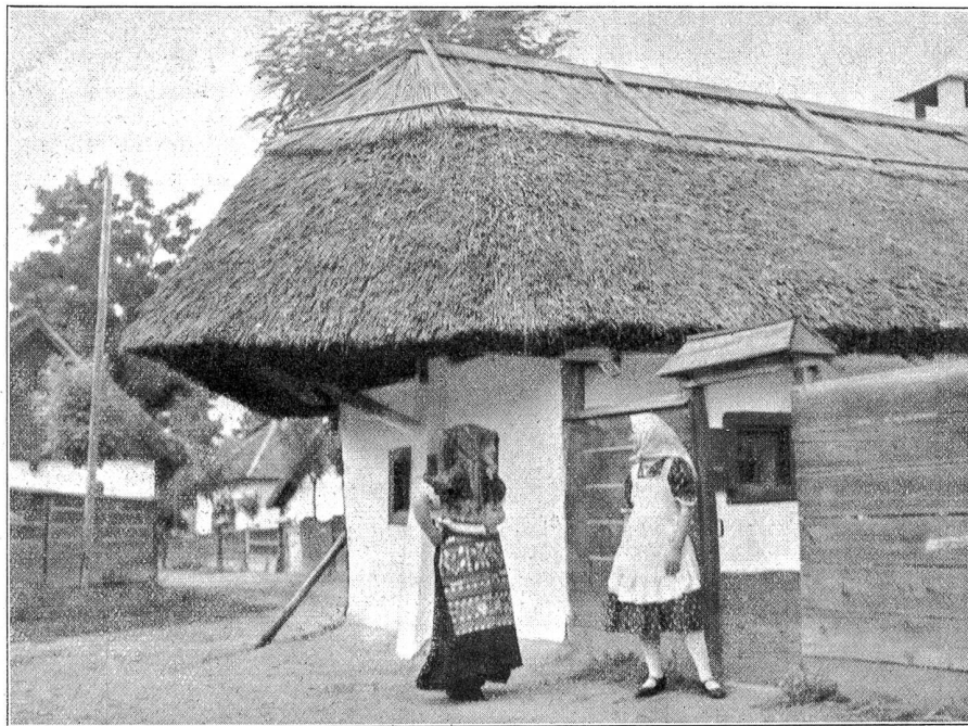
Die dicken, überhängenden Rohrdächer der Bauernhäuser sind fast mit der Hand zu erreichen.
