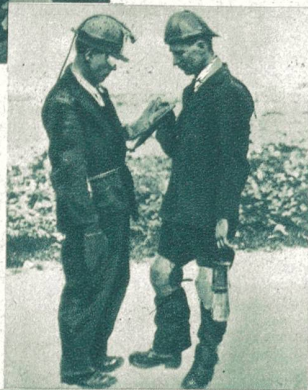
Unten: Neue Bergwerksarbeiter- Ausrüstungen in Devon- shire (England) zur Er- höhung der Sicherheit. Dazu gehören ein Helm, der mit Leuchtvorrich- tung versehen ist, Knie- schützer, Schienbein- schützer, Schutzbrillen und Panzerhandschuhe. (Photo Keystone)
