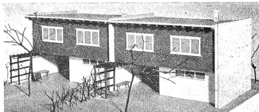
Holzhaus Kienzle. Reihenhaus.
