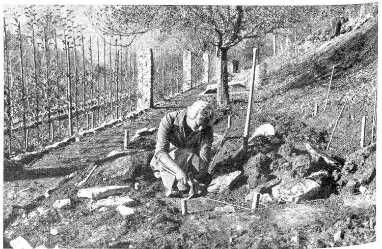
Werktätige Uebung beim Legen von Plattenwegen. Der neue Gewürzgarten wird angelegt.
