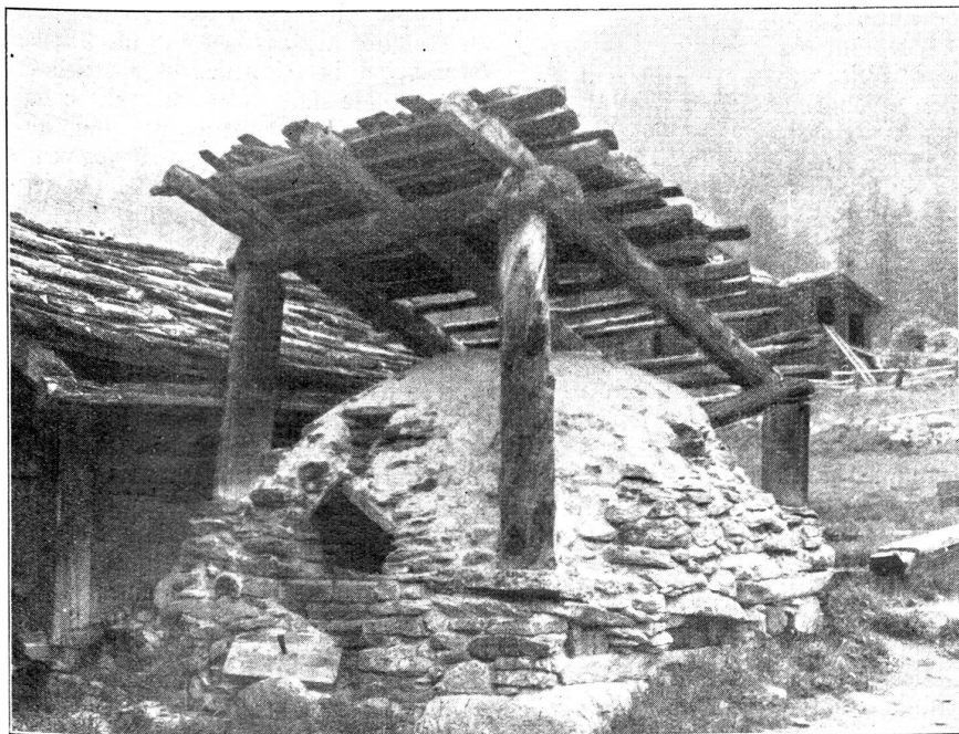
Backofen im Nikolaital.
