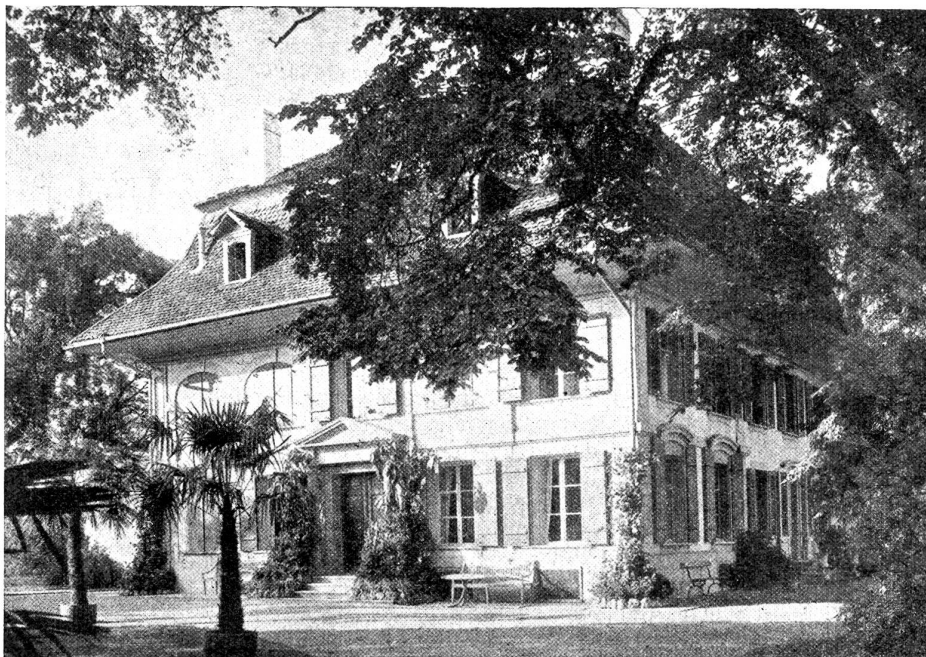
Die „Elfenau“ Ehemaliges Wohnhaus der russischen Grossfürstin Feodorowna.
