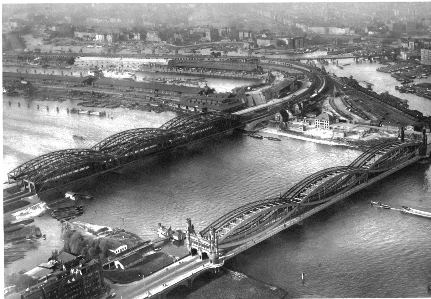
Hamburg, Blick auf die Elbebrücke
